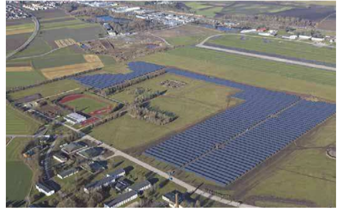
Die „Ehoch4“-Solaranlage mit mehr als 40.000 Photovoltaik-Modulen wird derzeit ans Netz angeschlossen. FOTO: EHOCH4
