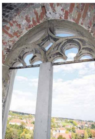
Bei den anderen Fensterbögen im Kirchturm ist noch das Originalmaßwerk vorhanden.
