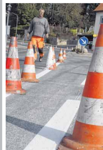
Es gibt Fahrbahnmarkierungen für die Bundesstraße in Scheer.
